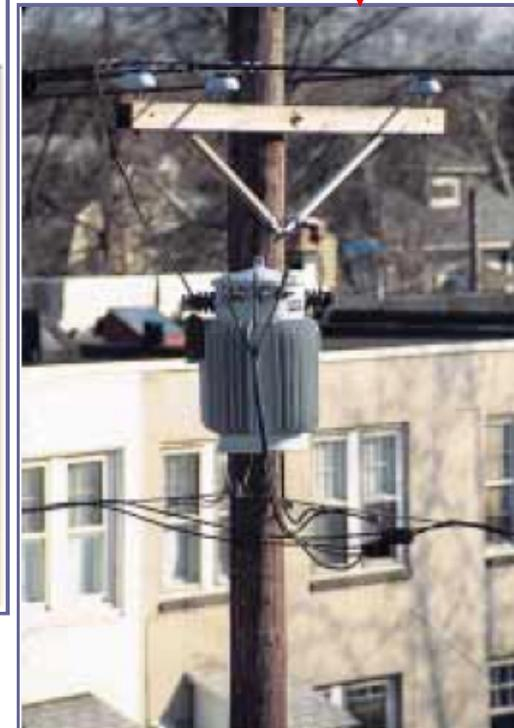
**Esquema del tendido eléctrico. A mayor voltaje en las líneas de transmisión, menor es la corriente, minimizando la pérdida durante el transporte.**
