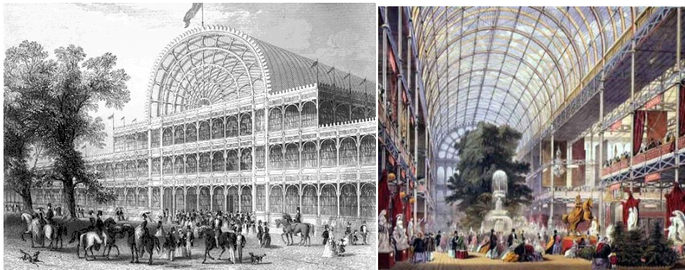
Fig. 2-3. Imágenes del Crystal Palace de Londres. Vistas exterior e interior de la época. Fuente: historiarte
