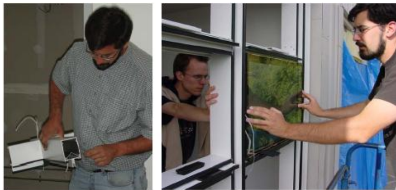
Fig. 2-48. Montaje del vidrio EC usando un sistema exterior de muro cortina con carpintería. Fuente: LBNL
