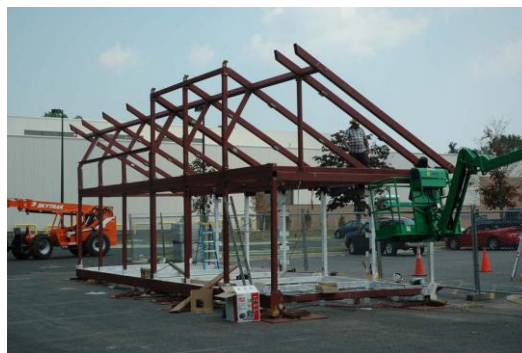
Fig. 2-20. Construcción de la casa solar UPM 2007 en el NAHB. Fuente: fotografía archivo Solar Decathlon 2007.
