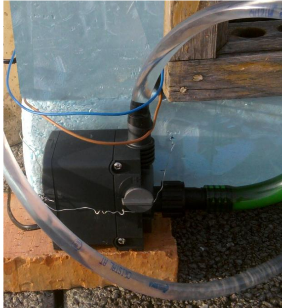
Fig. 7-33. Detalle de la bomba de circulación.
